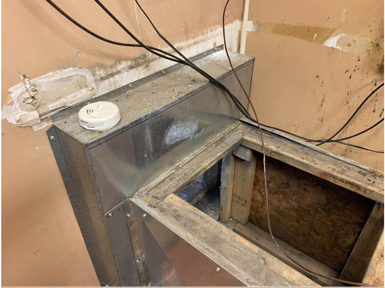
Mold on drywall
